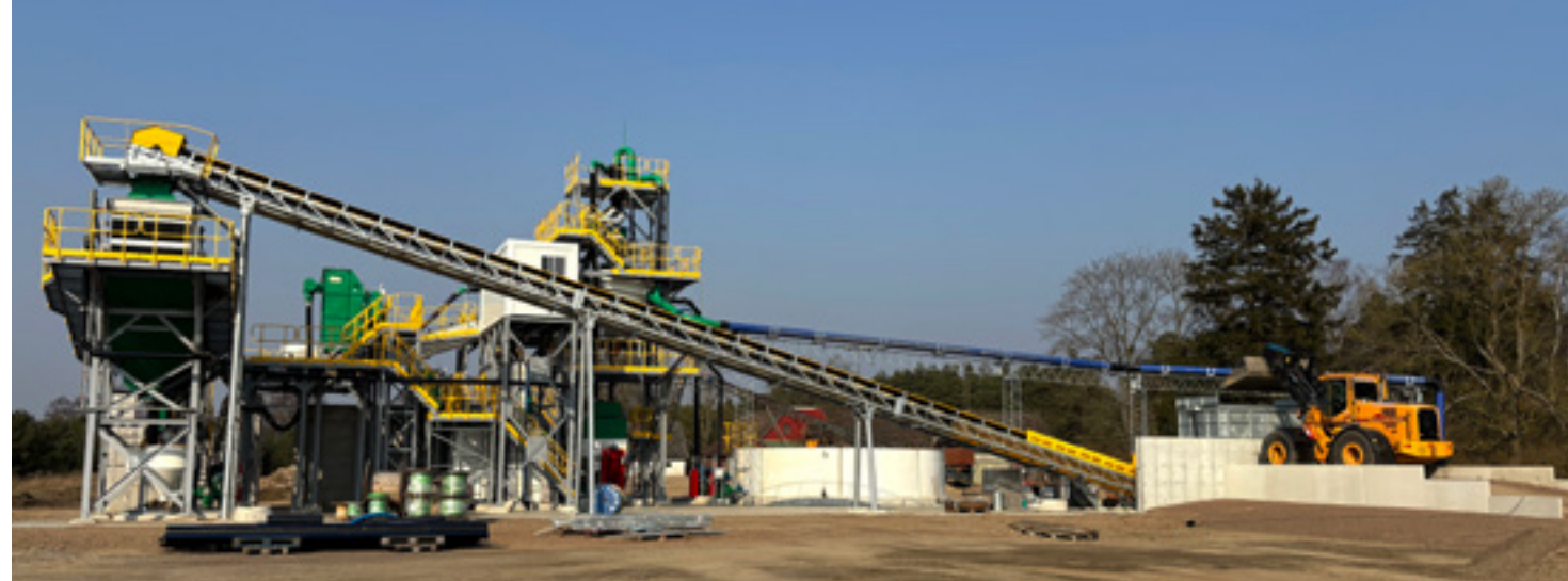
En ny anläggning för sandtvätt har byggts vid Vombverket under 2024.
