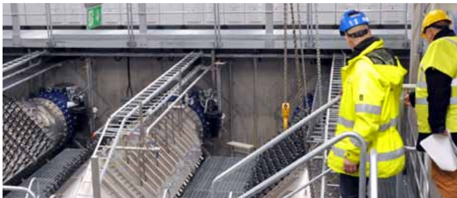
För att öka kapacitet och säkerhet vid Ringsjöverket har tre UV-aggregat, vardera sex meter långa, installerats i en nyuppförd byggnad, en investering på 64 miljoner kronor.
