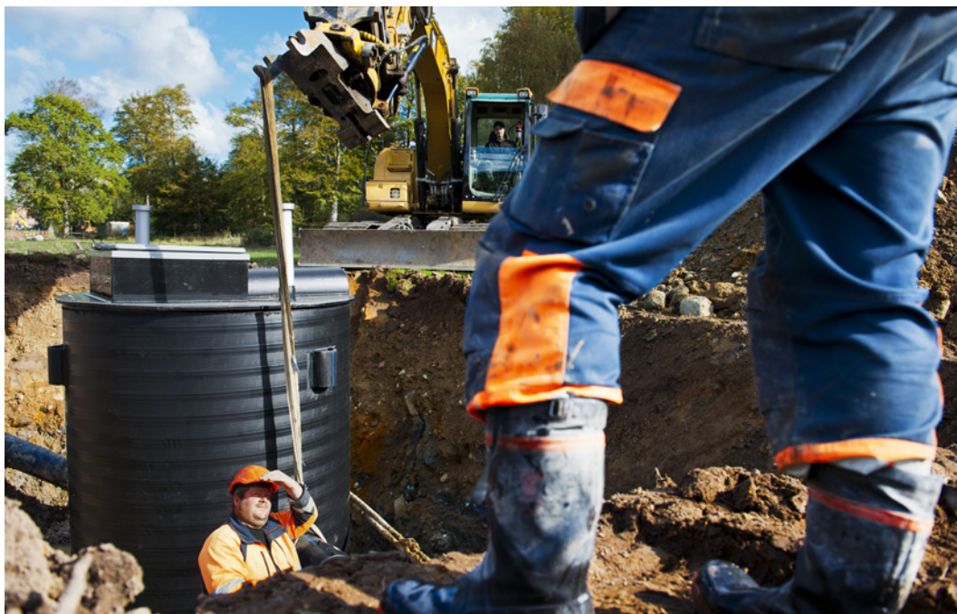
Anslutning av ledning mot Svedala.
