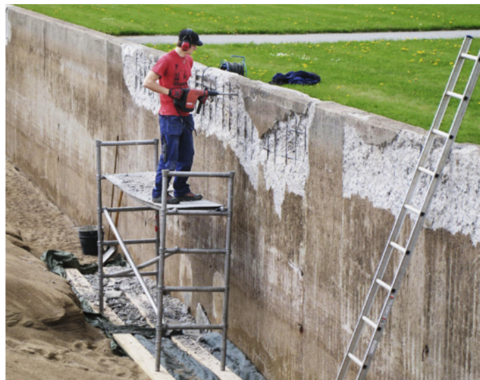
Lagning av långsamfilter.
