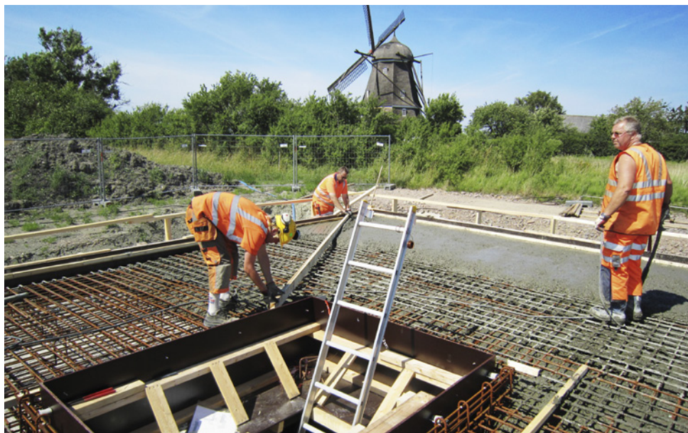
Lagning av långsamfilter.
