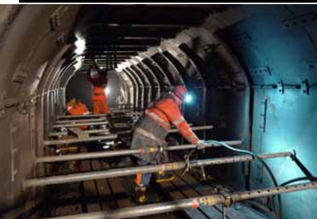
Reparation av huvudrasen 2009
