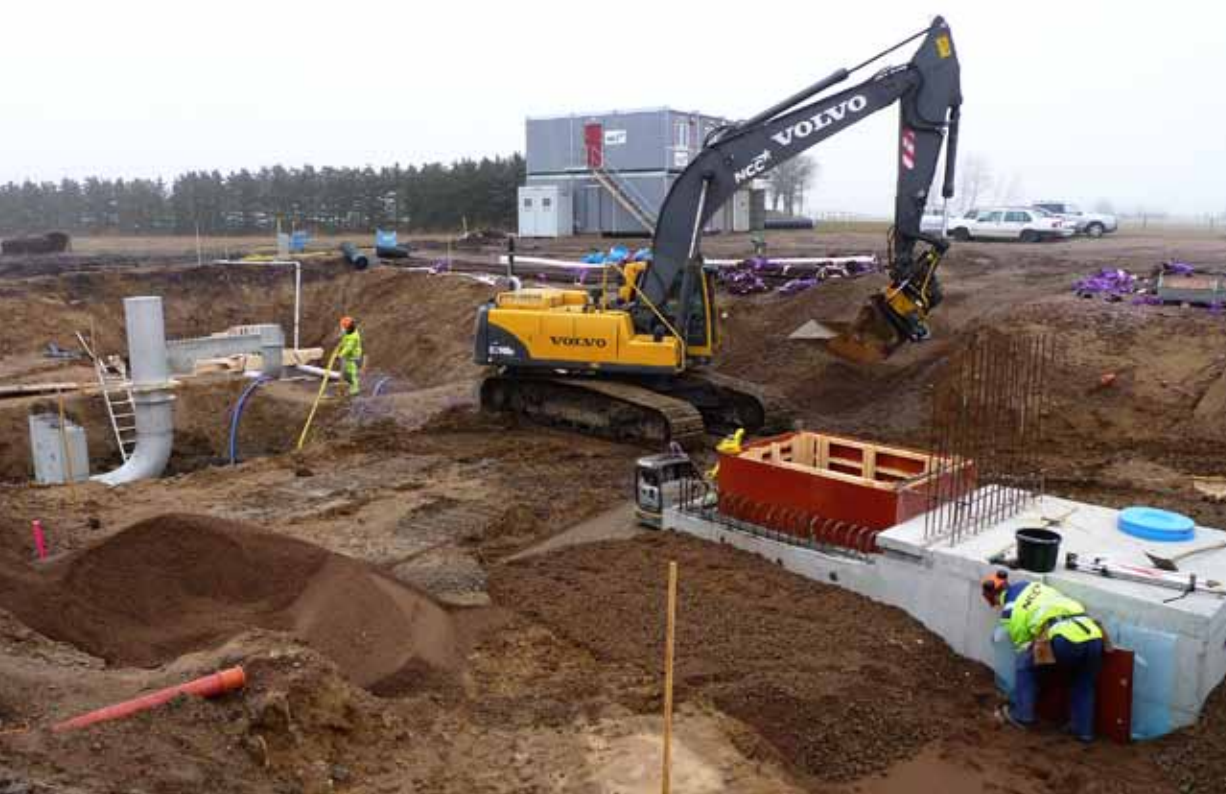
Byggnad av ny reservoar vid Tjutebro
