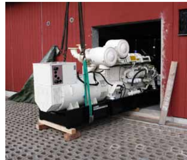
Inlyftning av reservkrafts- aggregat i Teckomatorp
