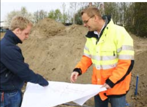
Anläggande av ledning till Kungshult.
