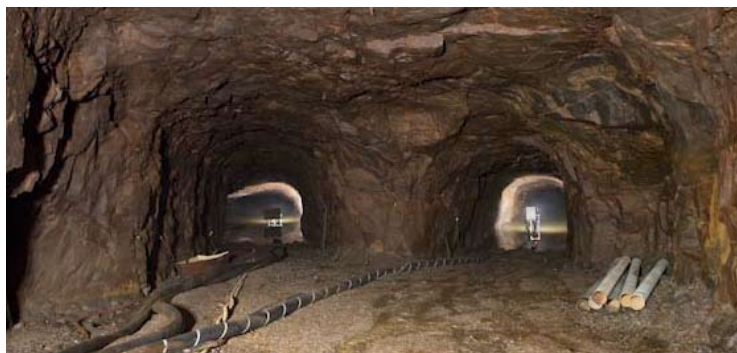
Utpumpning av vatten vid tunnelras, 2009.
