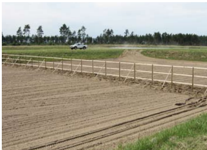
Delningssväggen under konstruktion i en av de två studerade infiltrationsdammarna.
