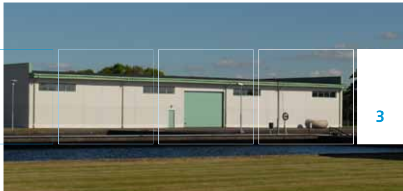
Nytt kallförråd vid Ringsjöverket.
