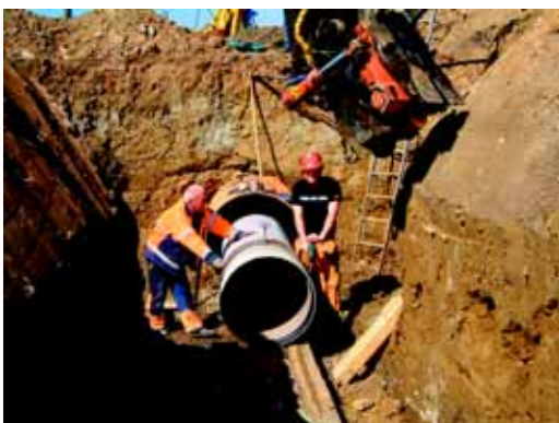
Lansering av ledning i skyddsrör
