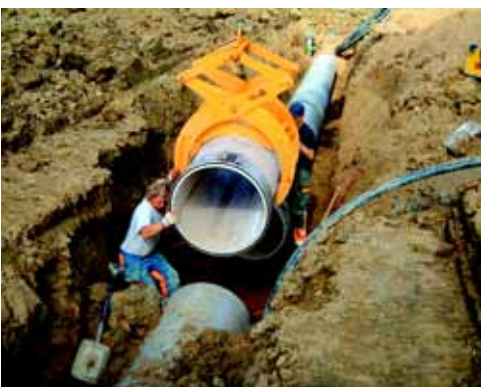
Sammankoppling av rörändar
