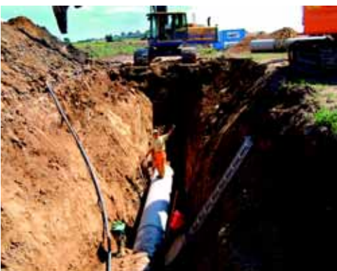
Läggning av rör i djupschakt
