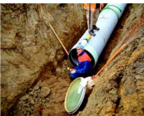
Klart för inspektion av de första lagda rören för Ringsjöledning 2
