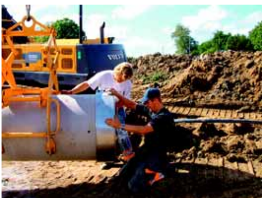
Tillpassning av rörkoppling
