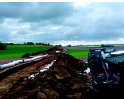
Förberedande arbete för rörläggning
