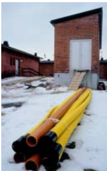
Ombyggnation av sugbrunn Vomb
