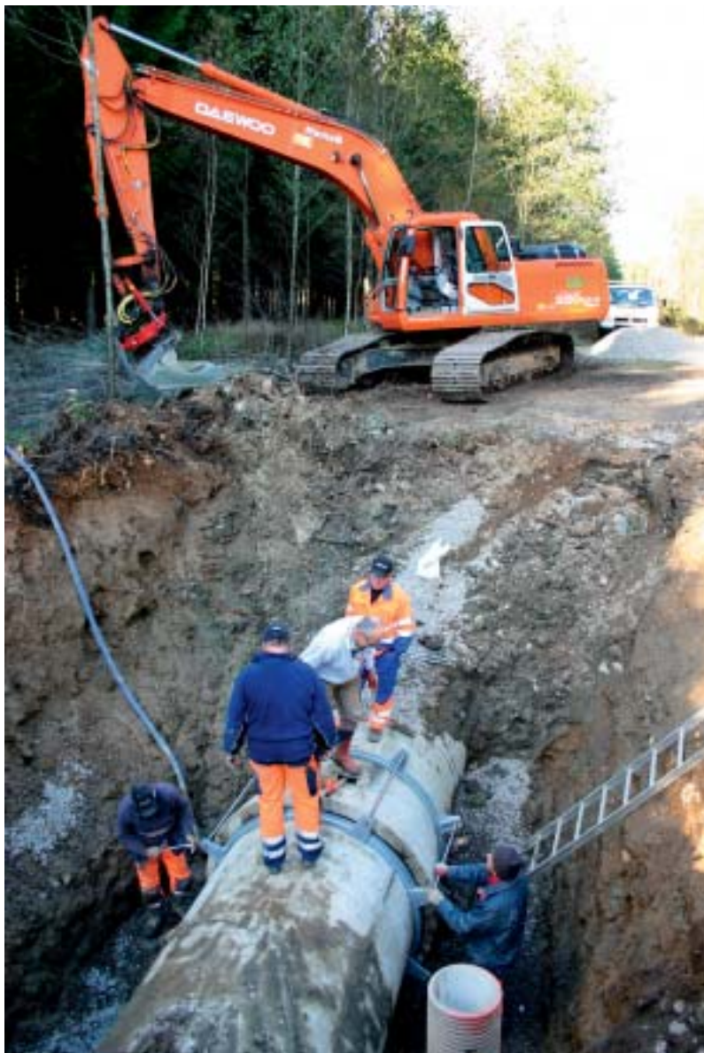
Reparation av råvattenledning under drift.
